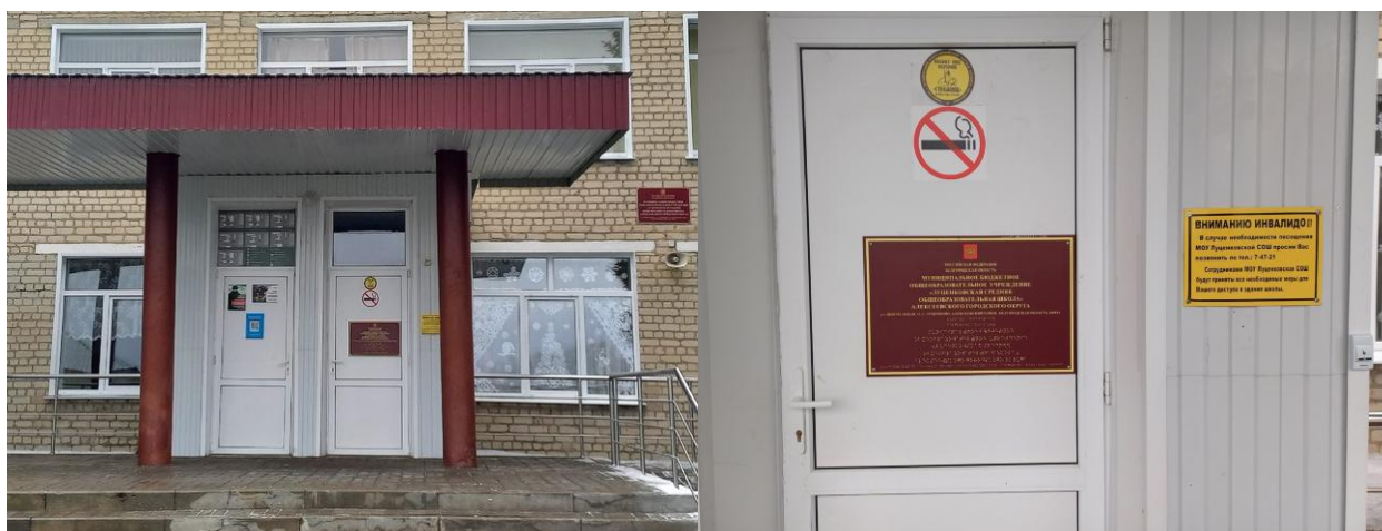
Вход в здание
